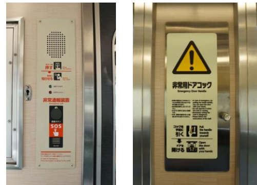
非常通報装置・非常用ドアロック
