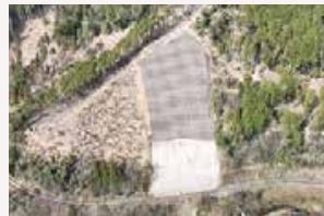
復旧が完了した崩壊斜面(叡山電車)
