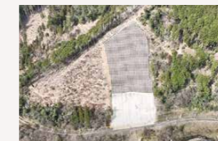
復旧が完了した崩壊斜面(叡山電車)
