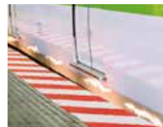
注意喚起シートとホーム足下灯
