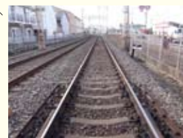
ロングレール
