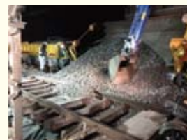
道床交換作業
