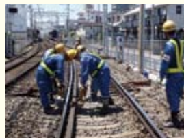
道床突固め作業
