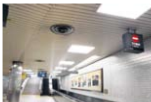
駅照明のLED化(出町柳駅)
