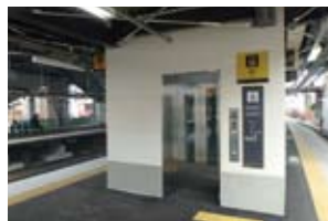
深草駅エレベーター
