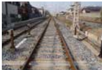
ロングレール
