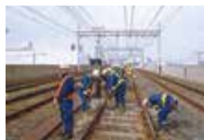
道床つき固め作業
