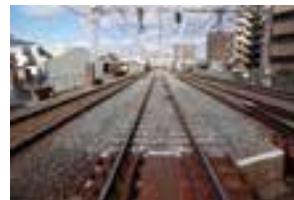
道床交換(完了)
