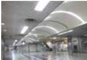
三条駅コンコースのLED照明
