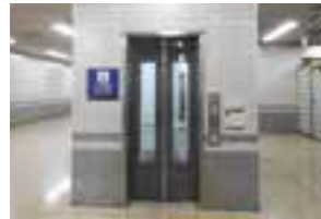
神宮丸太町駅エレベーター
