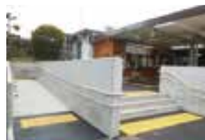
村野駅スロープ
