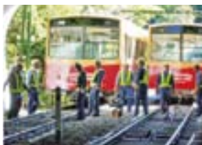
鋼索線の点検・整備
