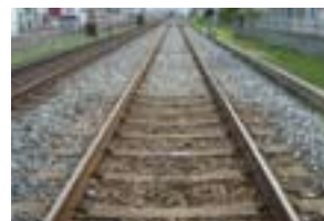
道床交換(完了)
