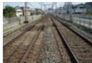
ロングレール
