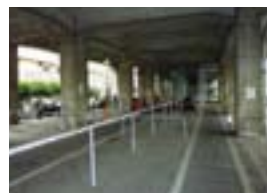
高架橋耐震補強
