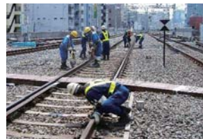
道床つき固め作業
