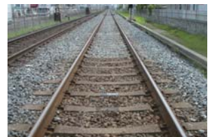
道床交換(完了)
