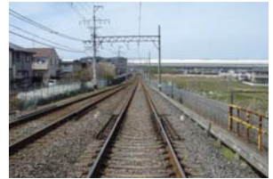
ロングレール
