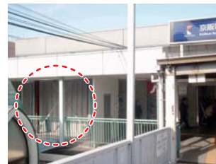
橋上駅舎への耐震補強部材の設置状況
