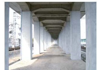
高架橋耐震補強
