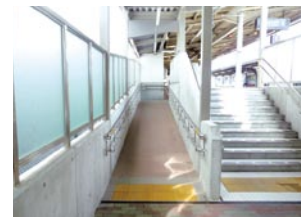
スロープ(星ヶ丘駅)
