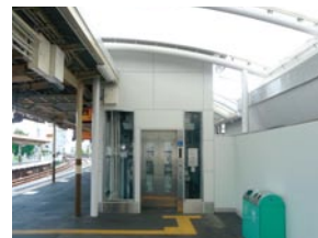
エレベーター(八幡市駅)
