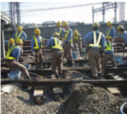
▲分岐まくら木交換作業
