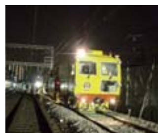
◀ 道床突固め作業
