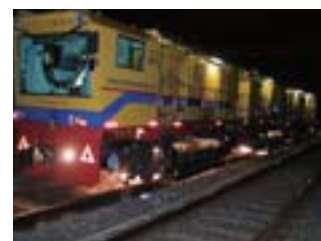
◀ レール削正作業
