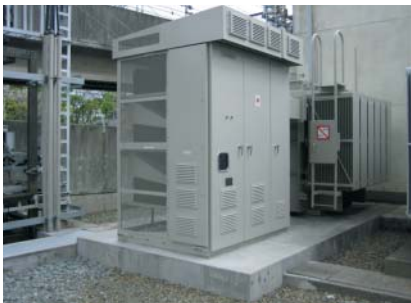
▲ヒートパイプ整流器
