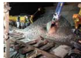
道床交換作業
