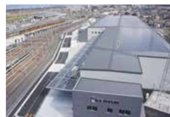
屋上の太陽光パネル
