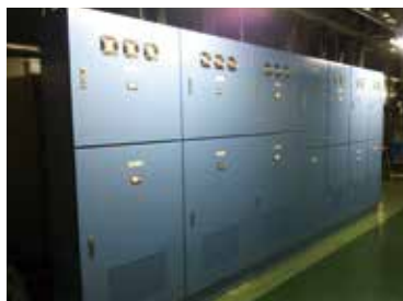
新しい空調システム
