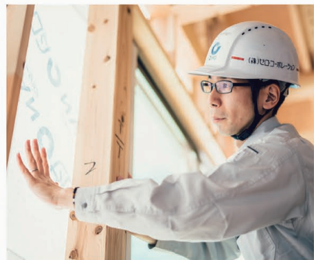
■水かけ試験で雨水の建物内部への浸入を素手でチェック
