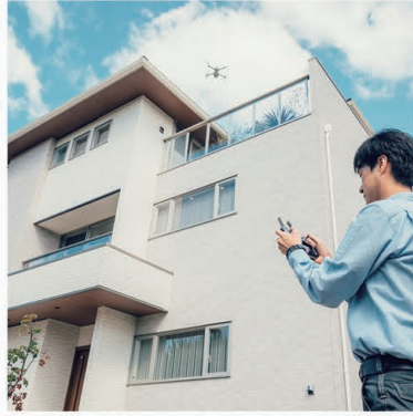
■屋根や外壁など、目視しにくい部分はドローンで撮影して広範囲にチェックします。
