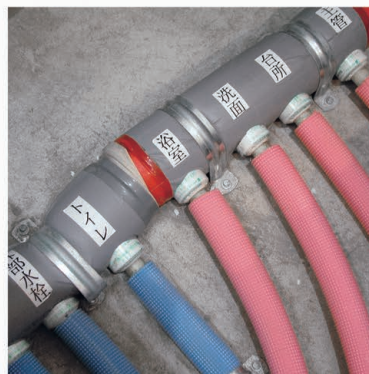
■各給水・給湯栓を一つずつヘッダー接続することで、漏水トラブルを減らし、万一のトラブル発生時にも他に影響がでにくい「ヘッダー配管」
