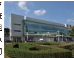
京阪くずは駅ビル南館
