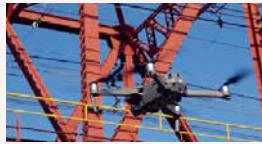
ドローンを活用した点検
