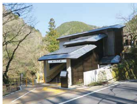
貴船口駅の新駅舎
