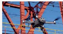
ドローンを活用した点検
