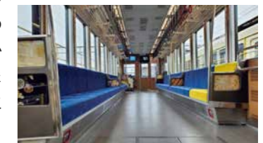
照明をLED化した叡山電鉄723号車の車内
