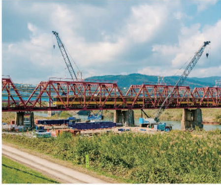
豪雨による河川増水に対応するための洗掘対策（橋脚補強）工事も行われていました
